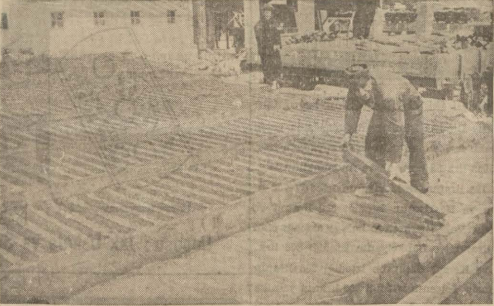
İstihsal edilen demir, işte bu toprak kalıplar içinde donuyor.
